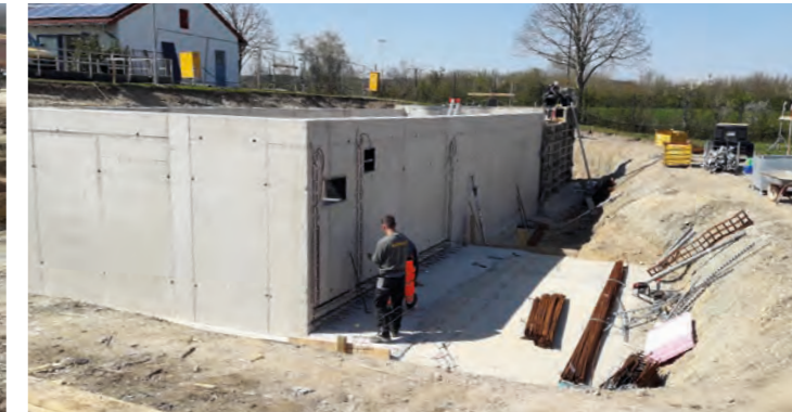
Bau der Bodenplatte sowie der Außenwände für das neue Vorklärbecken zwischen dem bestehenden Sandfang und der Belebungsbecken.
