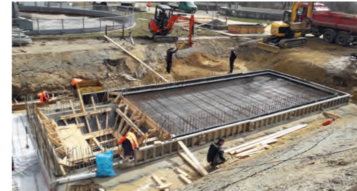
Bau der Bodenplatte sowie der Außenwände für das neue Vorklärbecken zwischen dem bestehenden Sandfang und der Belebungsbecken.
