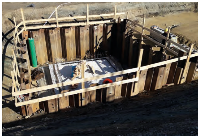
Auf Grund der schwierigen Bodenverhältnisse musste der Gas- keller im Betriebsgebäude 2 und der Trichter beim Vorklärbecken mit Spundwänden gesichert werden.
