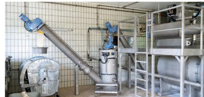
Montage der neuen Kompaktanlage mit Rechen sowie integrier- tem Sand- und Fettfang. Im bestehenden Maschinenhaus wurde eine neue maschinelle Überschussschlammeindickung montiert.
