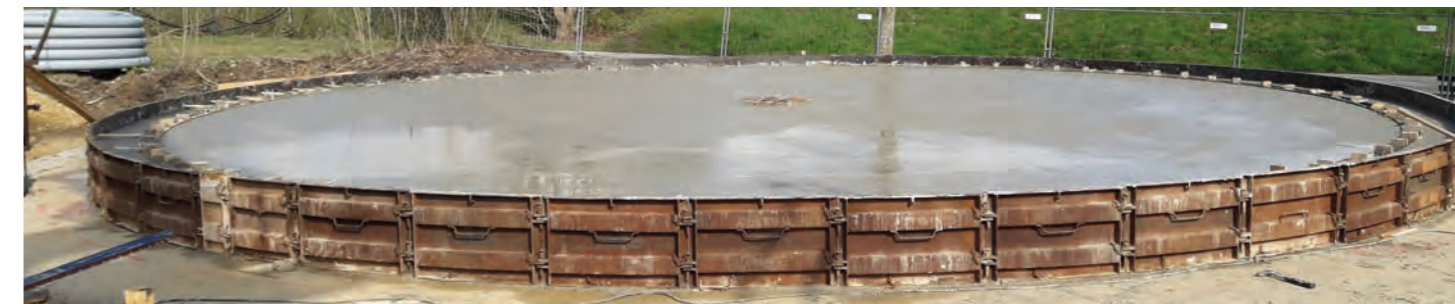
Bau der Bodenplatte sowie der Außenwände für das neue Vorklärbecken zwischen dem bestehenden Sandfang und der Belebungsbecken.
