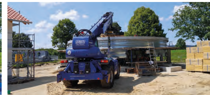
Erstellung der runden Bodenplatte für den Klärschlammfallbehälter. Aufstellung des Klärschlammfallbehälters (Fermenter) als zylind- rischer Stahlbehälter mit gasdichtem Edelstahlmembrandach. Neben an erfolgte die Aufstellung eines Trockengasspeicher mit zentral aufgehängtem Gasspeicherballon.
