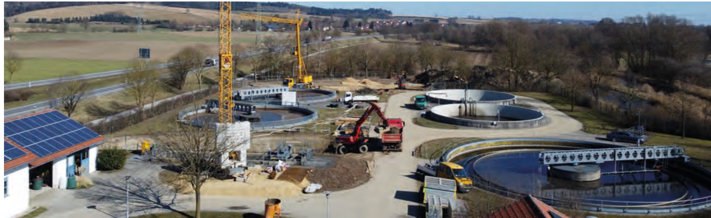
Übersicht über die gesamte Baustelle mit zwei Baufeldern, Bau- feld 1 mit dem Betriebsgebäude 2 (im Hintergrund sichtbar), Baufeld 2 das Vorklärbecken mit Pumpschacht (im Vordergrund). Baubeginn am 08.02.2021 durch die Fa. Berger Bau.
