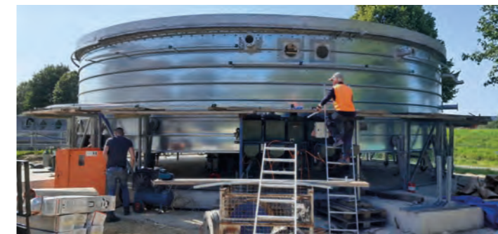
Erstellung der runden Bodenplatte für den Klärschlammfallbehälter. Aufstellung des Klärschlammfallbehälters (Fermenter) als zylind- rischer Stahlbehälter mit gasdichtem Edelstahlmembrandach. Neben an erfolgte die Aufstellung eines Trockengasspeicher mit zentral aufgehängtem Gasspeicherballon.
