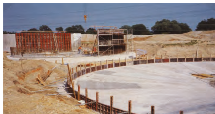
Bodenplatte Nachklärbecken und Schlammstillung
